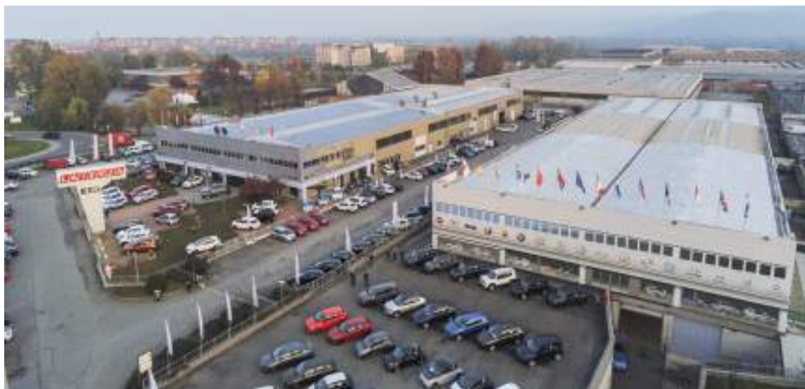
▼ LATERZA Settimo Torinese (TO) Bonifica copertura mq. 7.000
