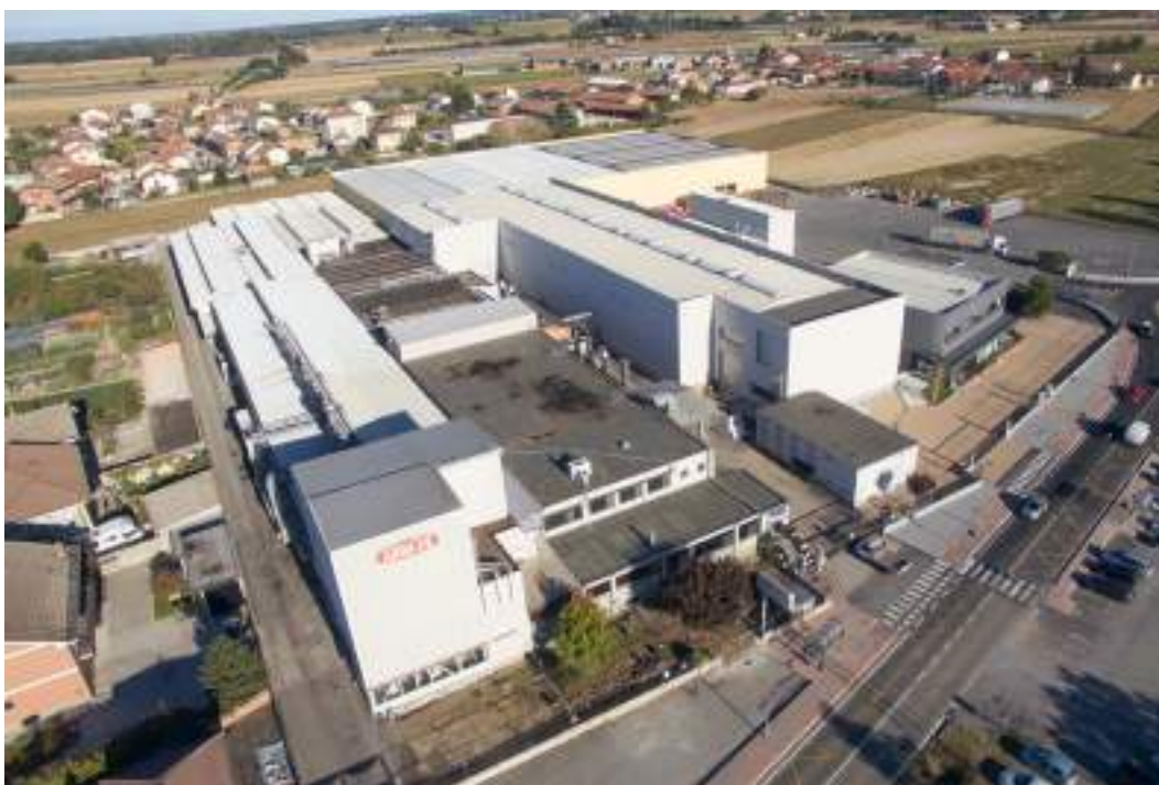
PASTA BERRU TO Carmagnola (TO) Nuova copertura mq. 10.500
