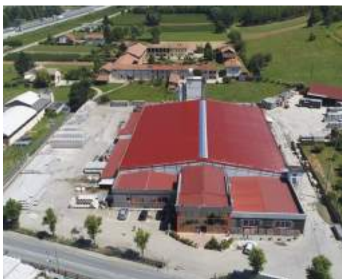
MCM - Isola d'Asti (AT) Bonifica copertura mq. ???
