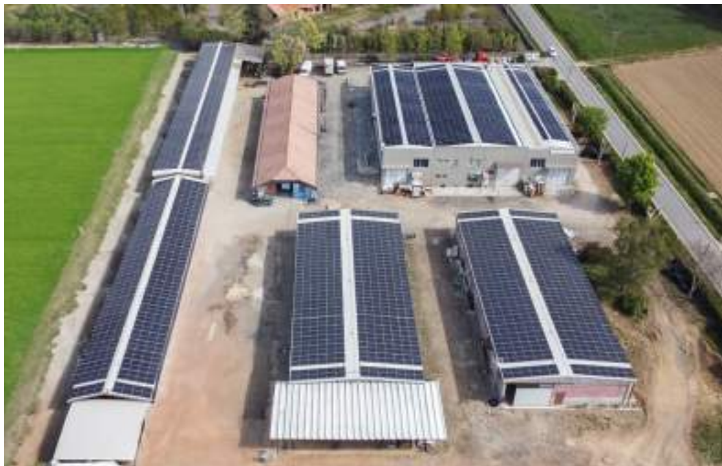
SUNPRIME - San Giorgio Canavese (TO) Bonifica copertura e fotovoltaico mq. 3.500
