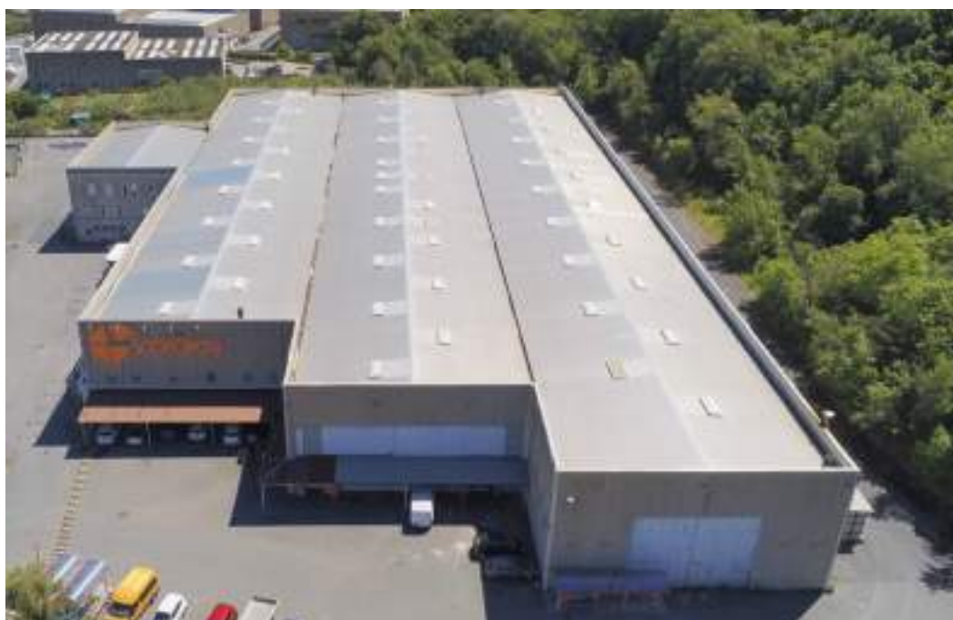
SOEGROSS Villanova d'Albenga (SV) Rifacimento copertura mq. 7.300
