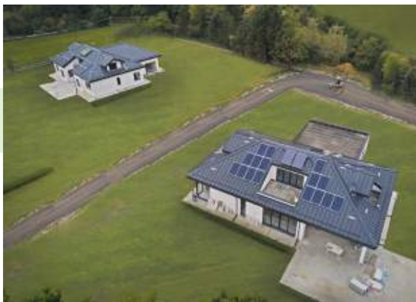
SRT Monticello d'Alba (CN) Bonifica copertura mq. 19.000
