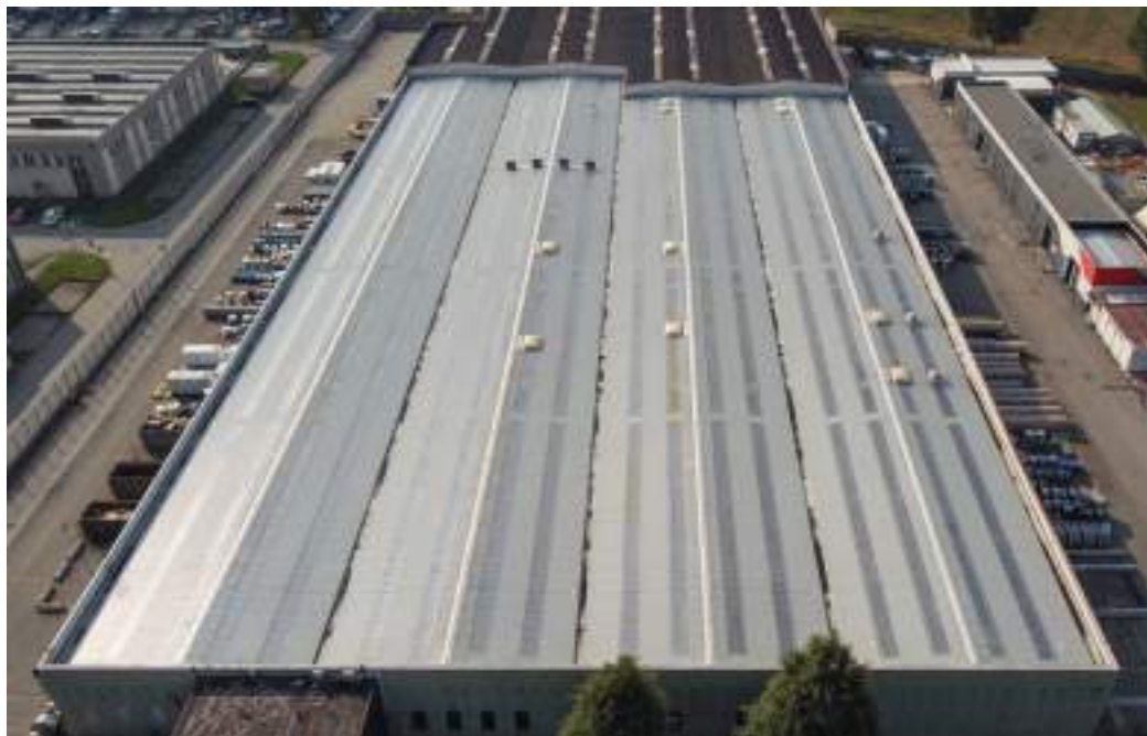
HITACHI - Piosasco (TO) Rifacimento copertura mq. 9.000
