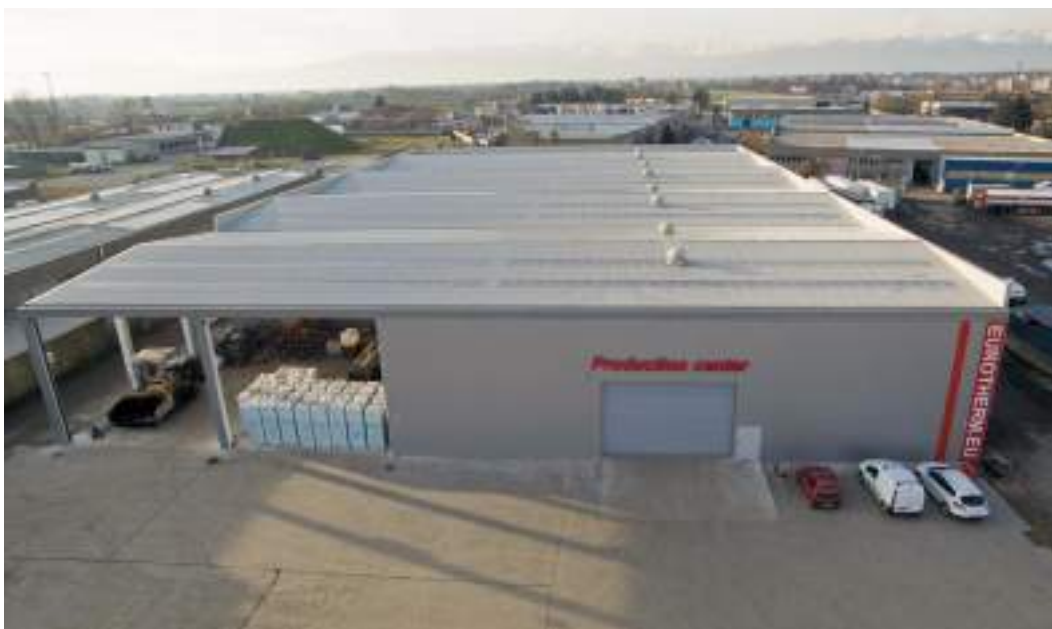
EUROTHERM Volpiano (TO) Bonifica copertura mq. 5.000
