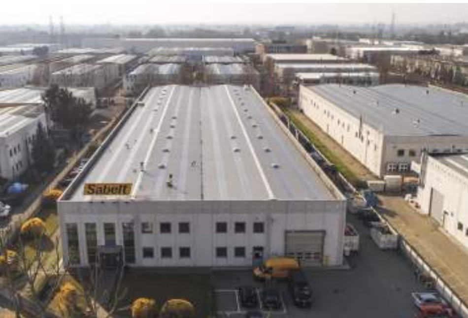
SABELT - Moncalieri (TO) Rifacimento copertura mq. 4.500
