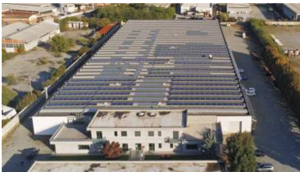
FURLANI - Cavaglià (BI) Rifacimento copertura mq. 4.500
